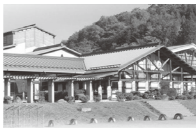
▲整備計画が進められている旧栗駒小学校
