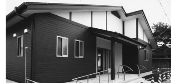
▲新築した地域集会施設
