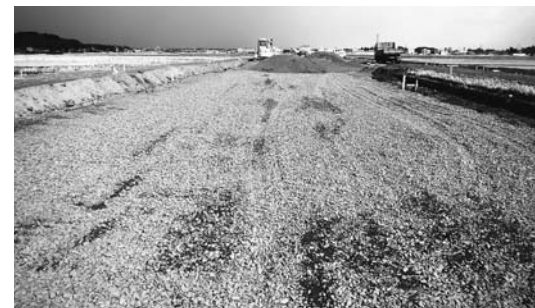
▲栗原中央西線の工事
