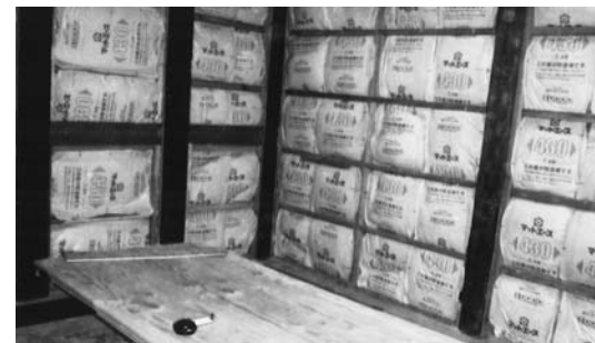
▲リフォーム助成による断熱工事
