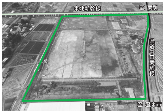
▲造成工事中の第2大林農工団地
