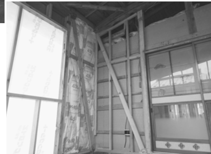
▲耐震改修工事の様子
