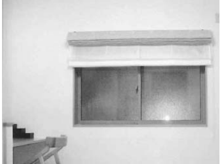
▲断熱性の高い窓で省エネ化
