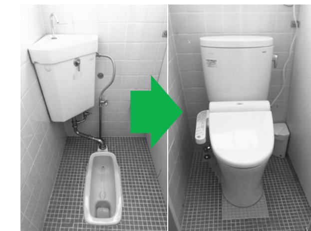
▲温水洗浄便座を設置し、洋式化したトイレ
