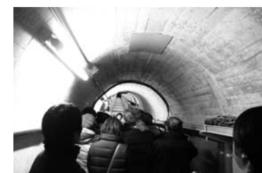
▲第7回講座は全体研修として、荒砥沢ダム監査廊を見学
