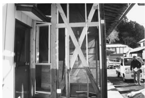
▲筋交いを入れ、外壁を補強した住宅
