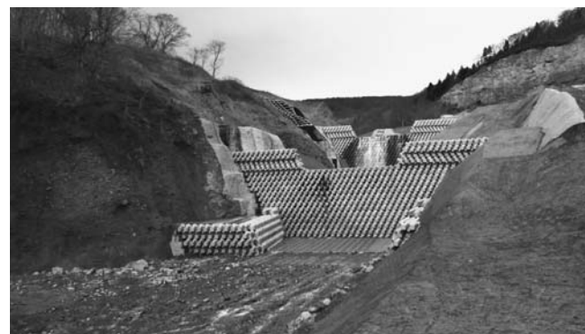
▲平成20年岩手・宮城内陸地震後、土砂流出防止のため建設してきた耕英東地区の砂防施設が完成(11月12日)
