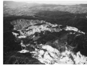
▲荒砥沢ダム上流部地すべり地帯
