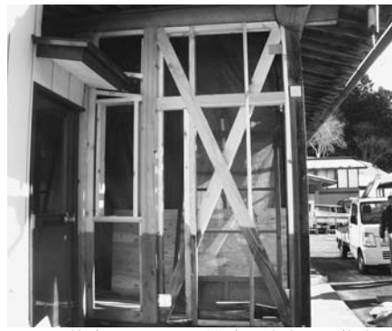
▲筋交いを入れ、外壁を補強した住宅
