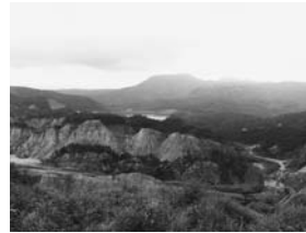
▲荒砥沢ダム上流部地すべり冠頭部からの眺め
