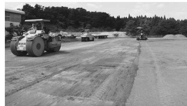
▲除染実施計画に基づく、学校などの除染作業
