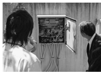
▲市役所内に各種センサーを設置
