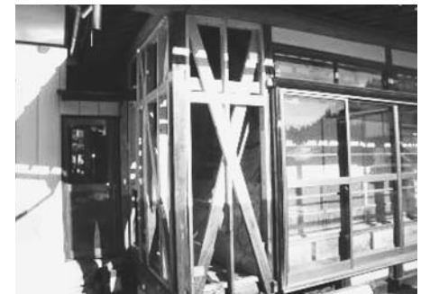
▲筋交いを入れ、外壁を補強した住宅
