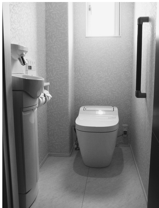
▲トイレの水洗化で快適な生活を！
