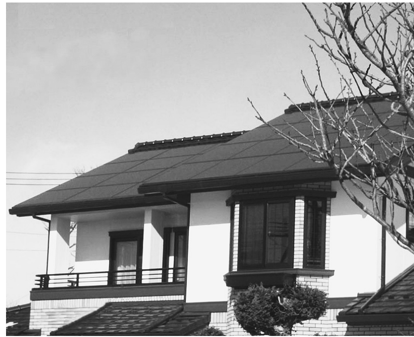
▲屋根の上に設置された太陽光発電システム
