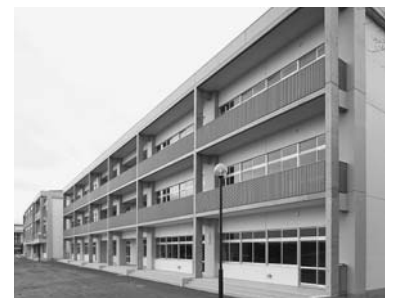
▲改築後の築館中学校校舎
