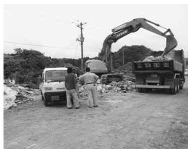
▲災害ごみの撤去作業
