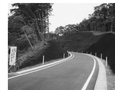
▲市道「馬場駒の湯線」の復旧状況
