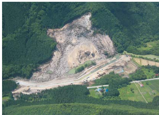
▲小川原地区の仮排水路通水(発災13日後)
