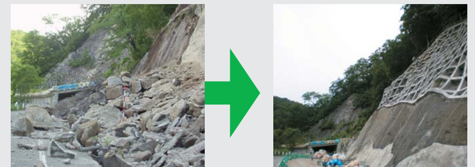
▲国道398号湯浜地区法面復旧工事状況(地図④)
