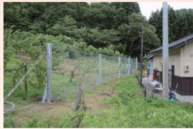
▲避難解除に向けた仮設落石防護柵の設置(地図⑯)
