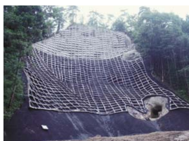
▲治山事業による復旧状況
