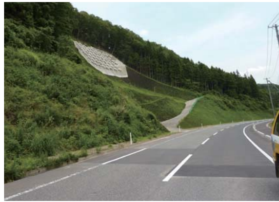
▲法面工事も完了し、一般車両が通行できました
