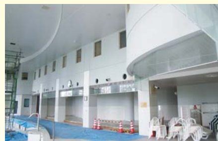
▲復旧工事が進むハイルザーム栗駒
