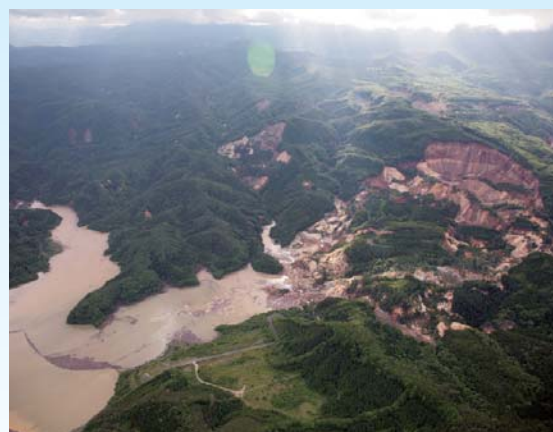
▲地震発生直後の荒砥沢ダム
