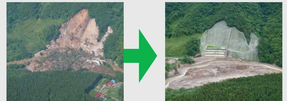
▲花山浅布地区山崩れと天然ダムの復旧工事状況(地図③)
