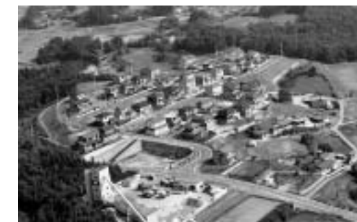
▲ 築館加倉団地
