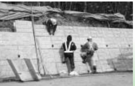
▲花山小川原地区国道398号擁壁法面保護工事
