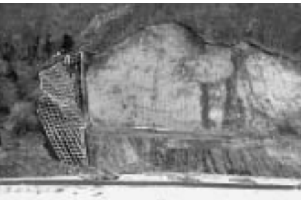
▲花山浅布地区崩落現場法枠工事
