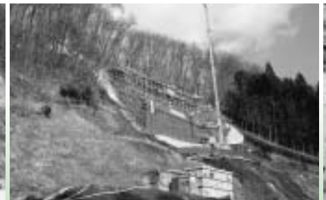
▲花山松ノ原地区国道398号法面吹き付け工事
