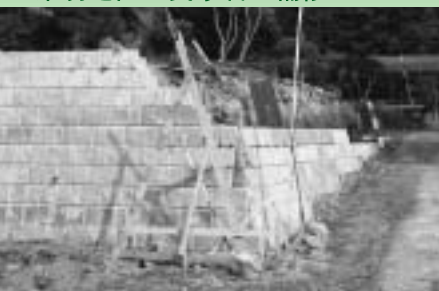
▼栗駒地区の民家石垣補修
