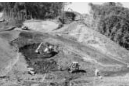
▲耕英馬場駒の湯線の本復旧現場
