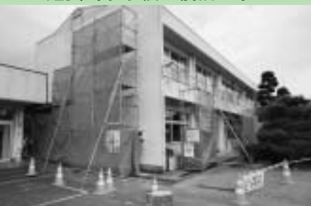
▼一迫長崎小学校の復旧工事
