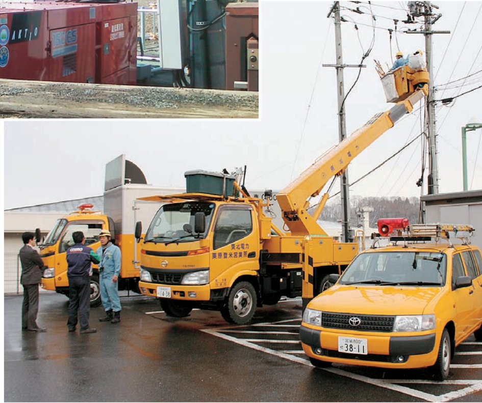
▲災害時支援協定企業による支援(電力復旧作業)
