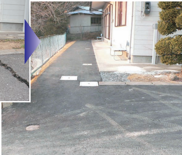
▼集会施設復旧費用の助成により元どおりに復旧
