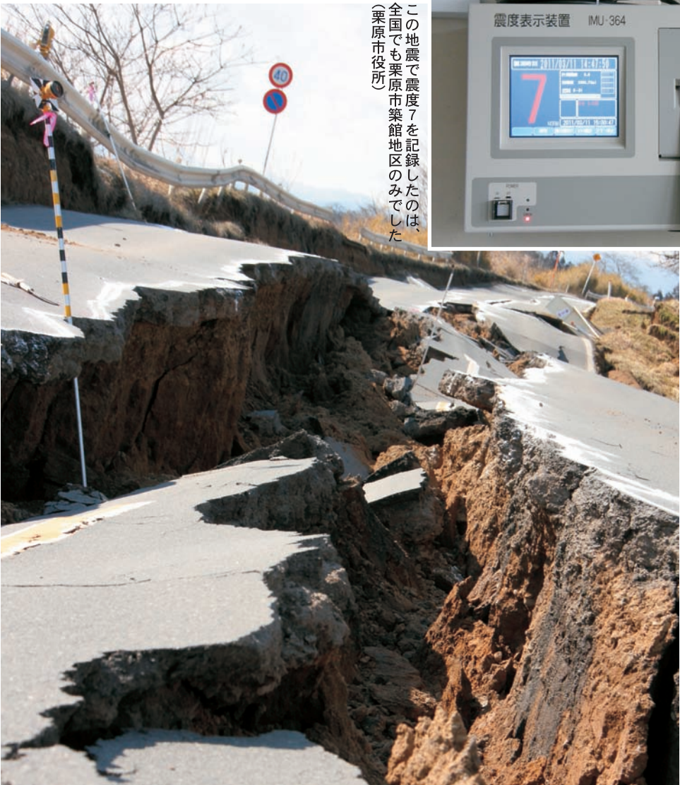
▲大地震で路面が大きく崩壊(若柳・市道沢辺大岡線)
