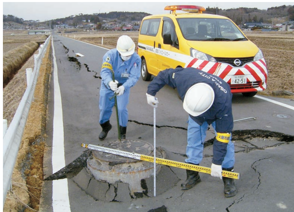
▶ 応援職員による下水道施設の被害調査
