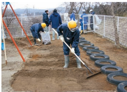
▲鳥矢崎幼稚園で行われた除染作業
