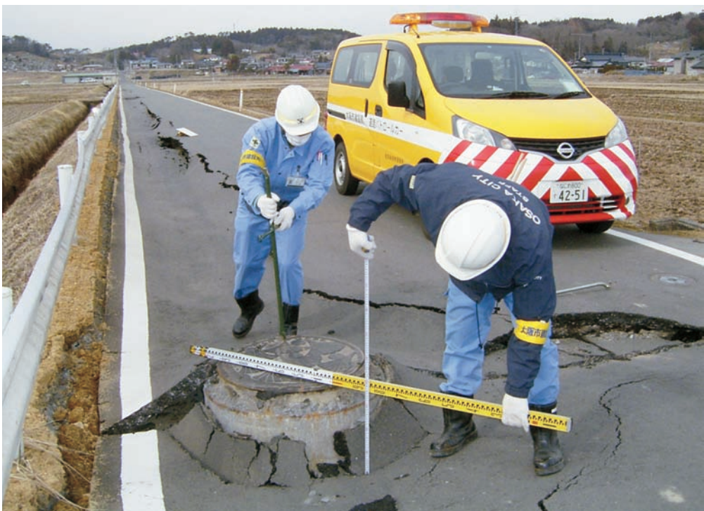
▶ 応援職員による下水道施設の被害調査
