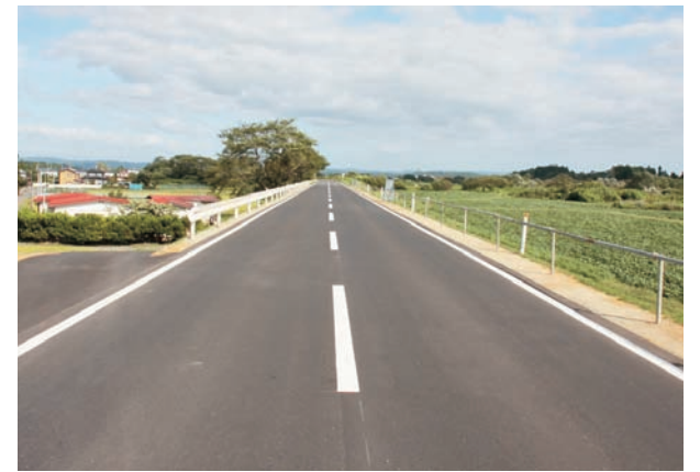
▲復旧工を行い、元どおりに通行できるようになりました
