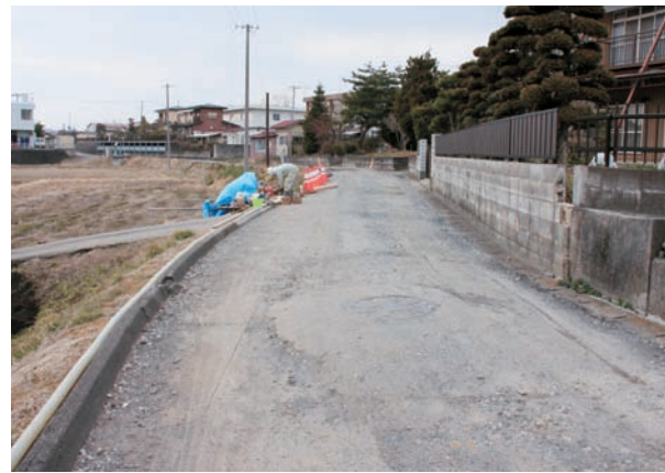
▲復旧工事を進めています
