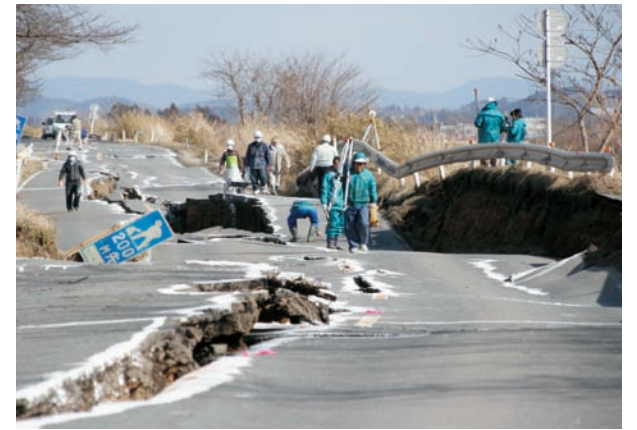
▲路面が波打つように大きく崩れました(若柳・市道沢辺大岡線)
