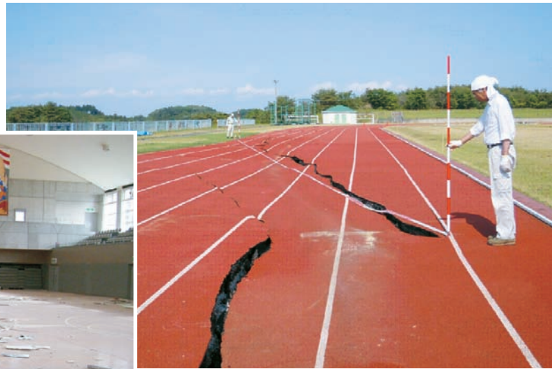
▲大きな亀裂が生じた築館陸上競技場
