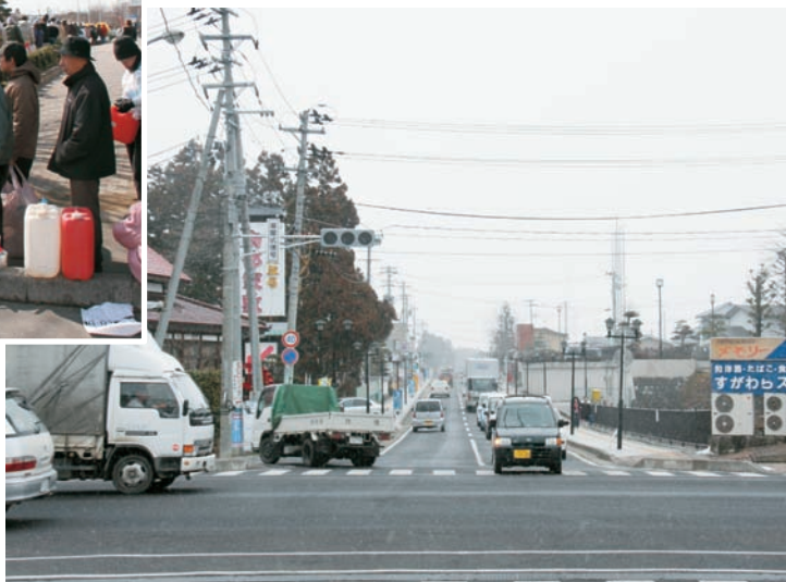
▼停電により信号が消えた交差点(市役所前)
