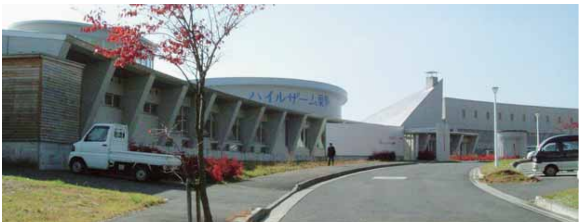
▲ 早期復旧を目指す温泉宿泊施設：「ハイルザーム栗駒」（栗駒地区）
