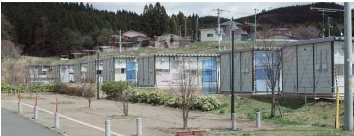
▲ 避難生活を送られている方々が入居している応急仮設住宅（花山地区）
