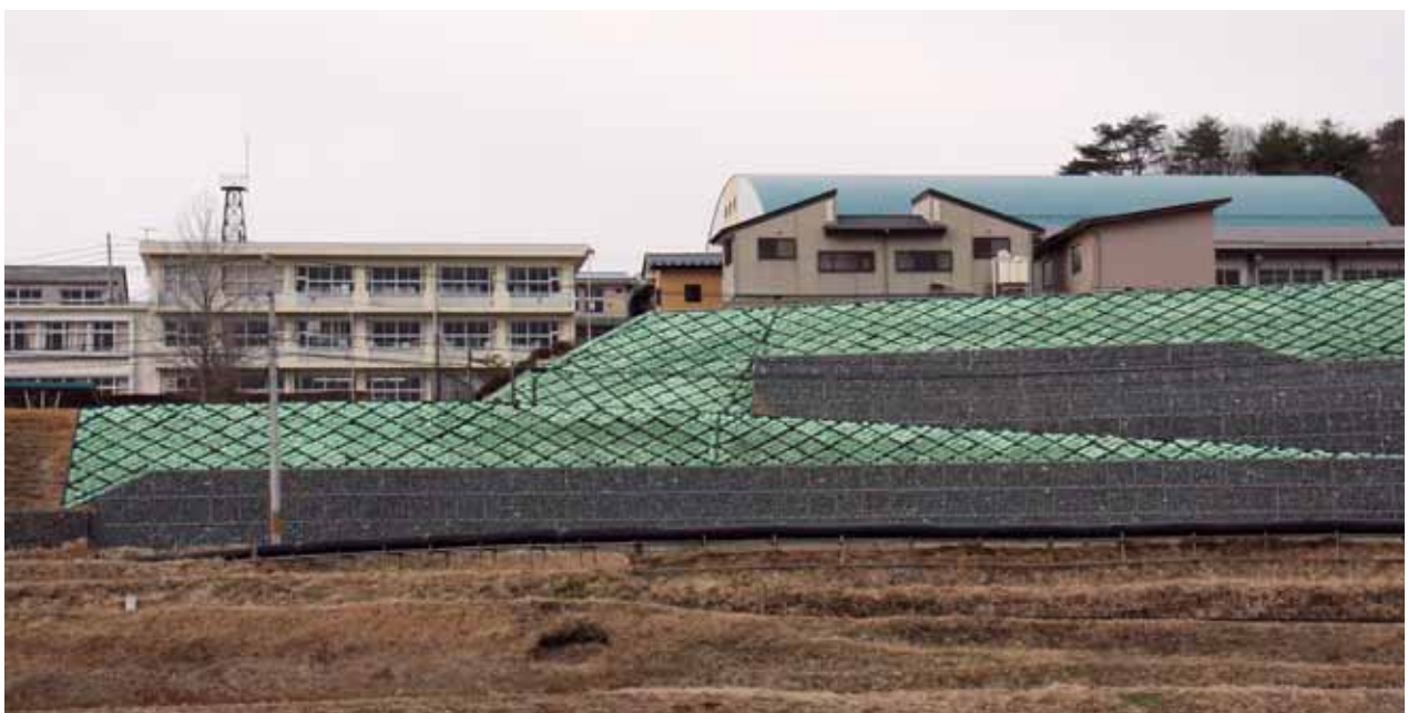
▲ ひび割れや土砂崩れがきれいに修復された宮城県岩ヶ崎高等学校鶯沢校舎前復旧工事（鶯沢地区）
