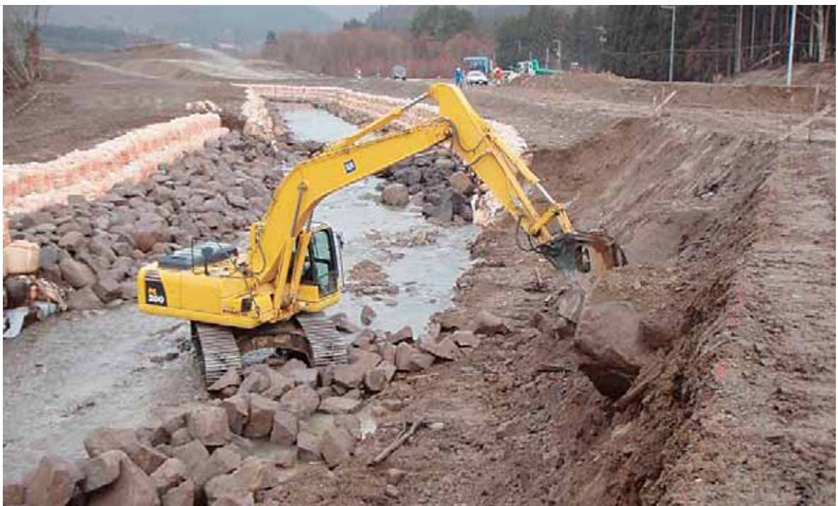
▲ 急ピッチで工事が進められた、大規模な土砂崩れにより河道閉塞となった迫川の小川原仮排水路工事（花山地区）
