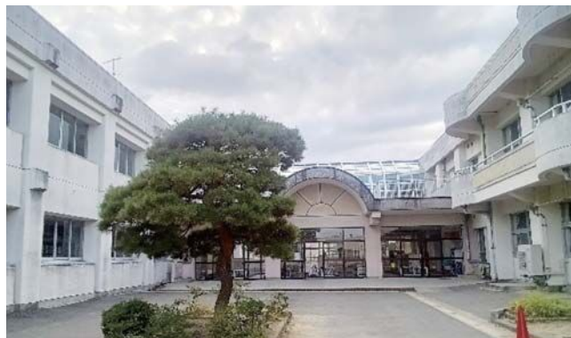
改修工事中の若柳小学校
