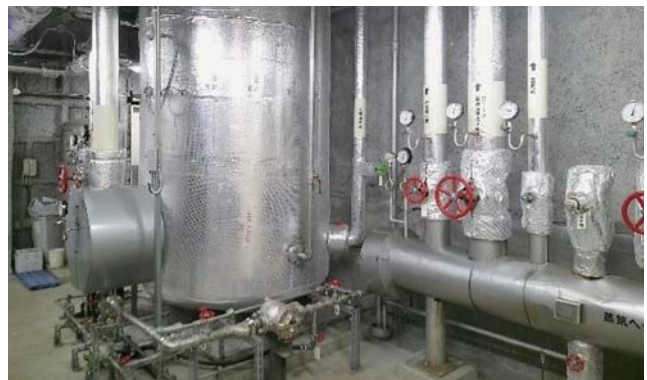
改修工事中の南部学校給食センター
