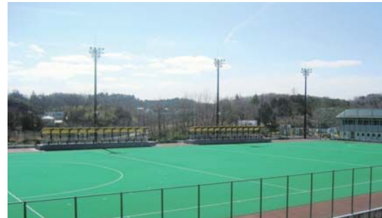
改修する築館多目的競技場コート
