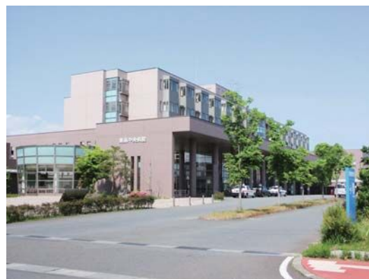
外壁屋上防水工事の修繕を予定している栗原中央病院
