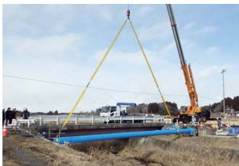
石綿セメント管更新工事の様子
