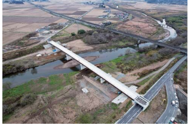
(仮称) 栗原東大橋
