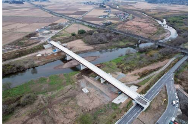
(仮称) 栗原東大橋
