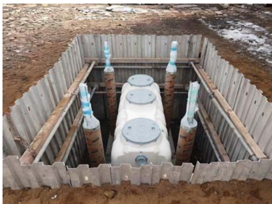
合併処理浄化槽設置工事の様子
