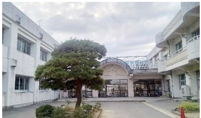
改修工事中の若柳小学校
