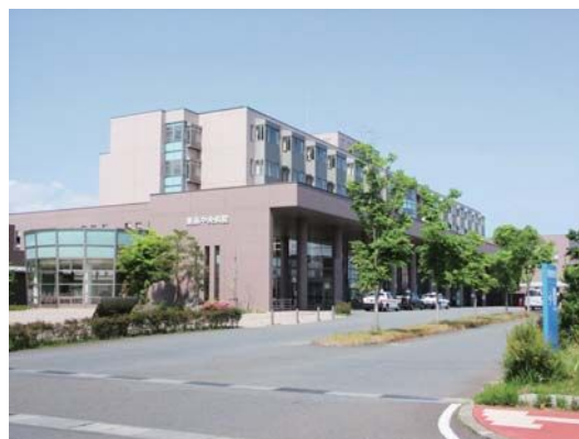
外壁屋上防水工事の修繕を予定している栗原中央病院
