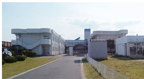
改修工事中の若柳小学校
