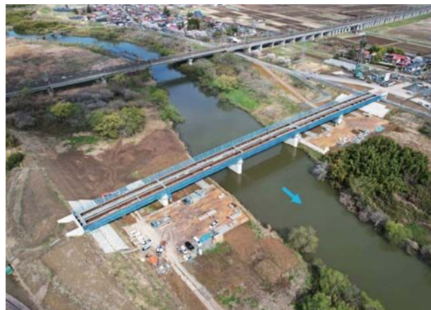
(仮称) 栗原東大橋
