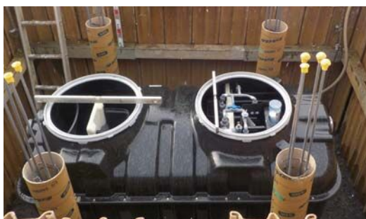
合併処理浄化槽設置工事の様子
