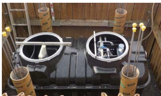
合併処理浄化槽設置工事の様子
