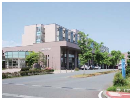
外壁屋上防水工事を予定している栗原中央病院
