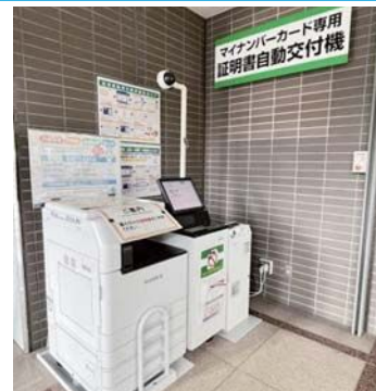
市役所本庁舎に設置した多機能端末機
