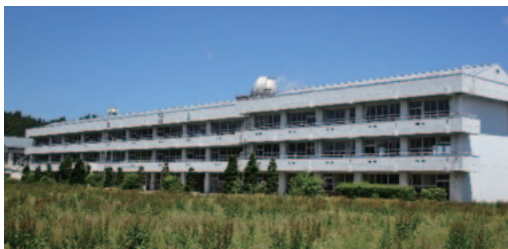
解体予定の旧鶯沢中学校
