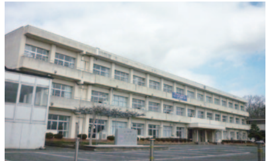
改修工事中の栗原南中学校
