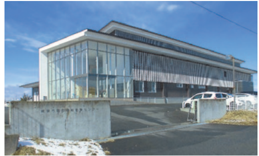
改修工事予定の南部学校給食センター
