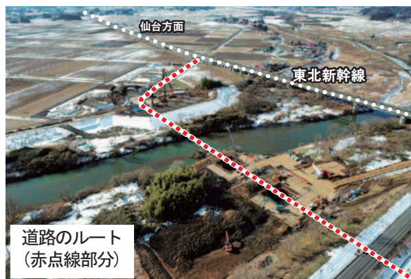
整備が進む大林線（仮称）栗原東大橋（若柳・志波姫地区）
