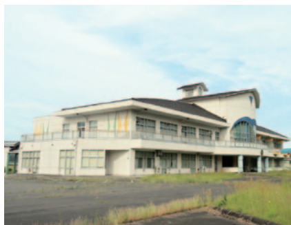
現況調査予定の旧富野小学校校舎
