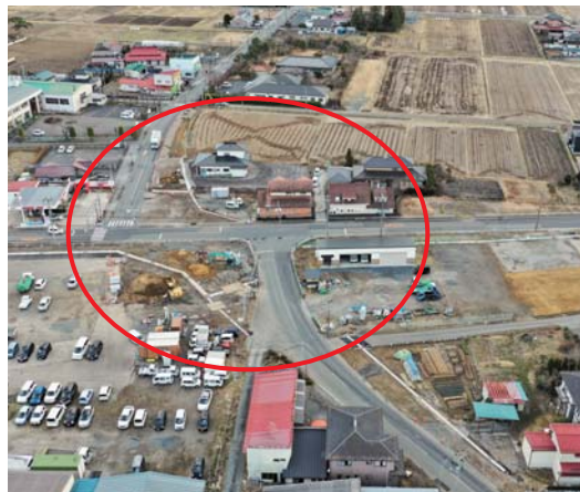
整備が進む御蔵線（志波姫地区）
