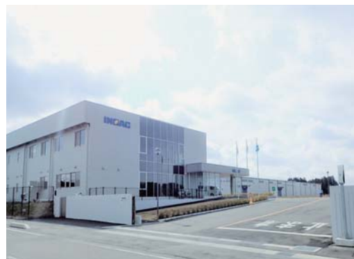
(株)東北イノアック築館工場
