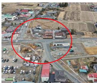
整備が進む御蔵線(志波姫地区)
