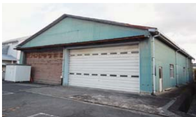
改築予定の志波姫総合支所の車庫・書庫
