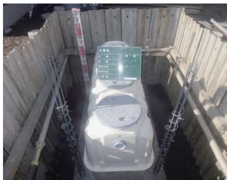
合併処理浄化槽設置工事の様子
