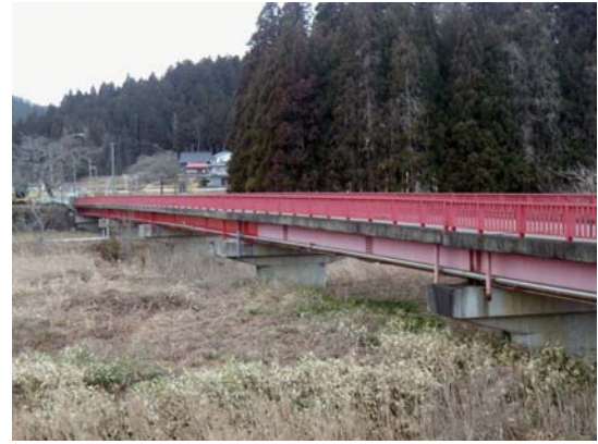
橋りょう長寿命化対策事業 (栗駒地区:御駒橋)
