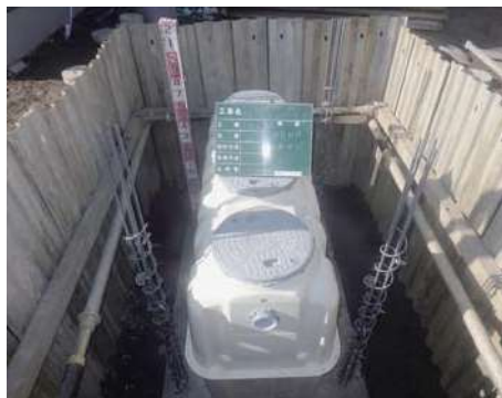
合併処理浄化槽設置工事の様子
