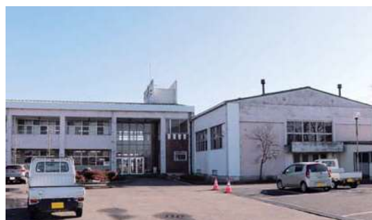
整備予定の志波姫公民館
