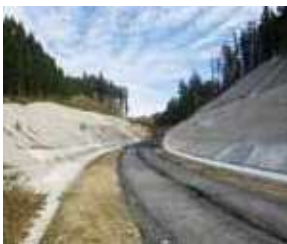
整備が進む片馬合萩荘線（金成地区）
