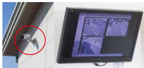
防犯カメラと監視モニター
