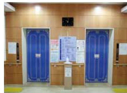
改修予定の栗原中央病院エレベーター
