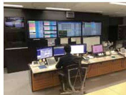
更新予定の消防指令装置
