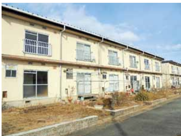
建替を行う市営中の茎住宅(高清水地区)
