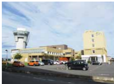
改修を行うくりはら交流プラザ
