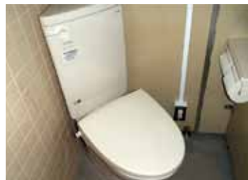
改修した洋式トイレ
