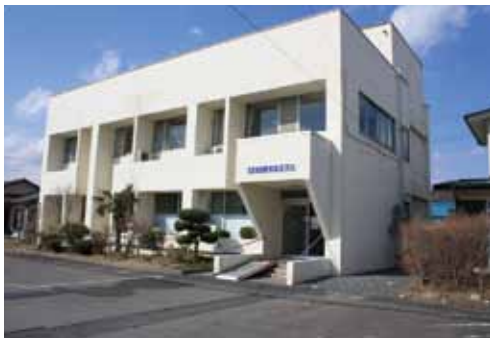
解体予定の旧花山診療所
