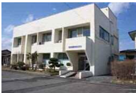
解体予定の旧花山診療所
