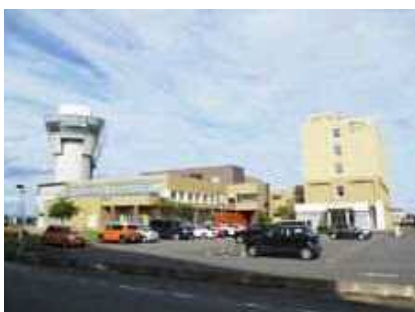
改修を行うくりはら交流プラザ
