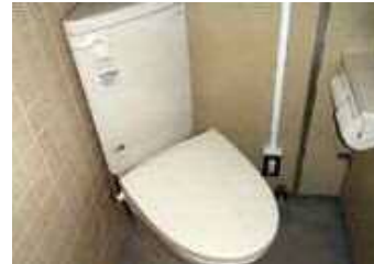
改修した洋式トイレ
