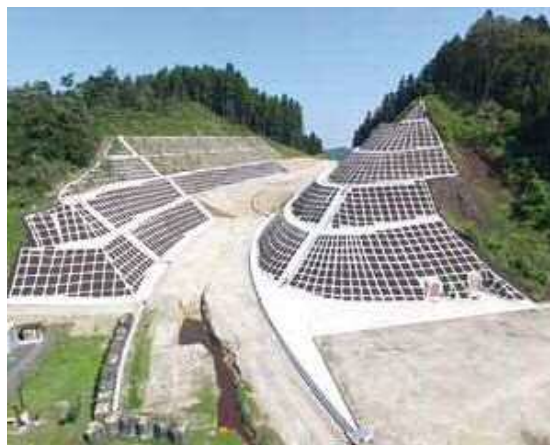
整備が進む清水目・嶋躰線(一迫地区)
