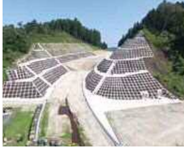
整備が進む清水目・嶋林線(一迫地区)
