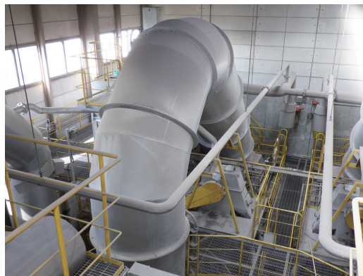
改良工事を行うクリーンセンター内の各機器
