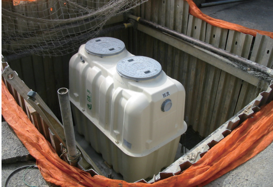
合併処理浄化槽設置工事の様子
