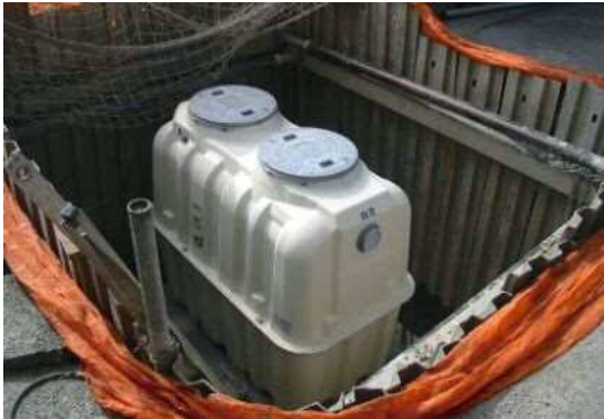
合併処理浄化槽設置工事の様子
