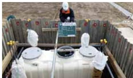
合併処理浄化槽設置工事の様子
