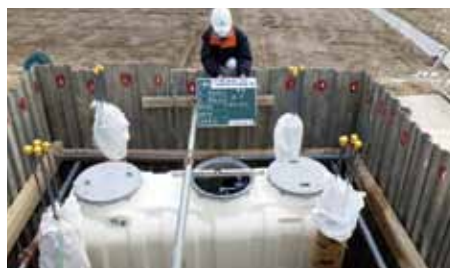
合併処理浄化槽設置工事の様子
