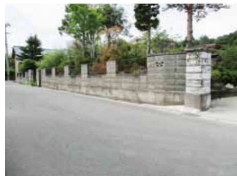
除却前のブロック塀
