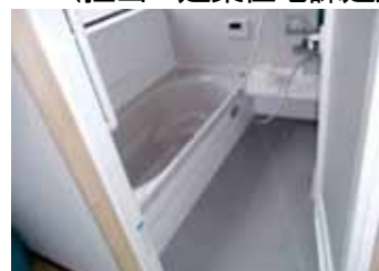
浴室のリフォーム工事
