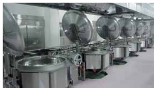
開業準備が進む(仮称)北部学校給食センター(金成地区)
