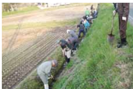
共同活動による水路の泥上げ作業
