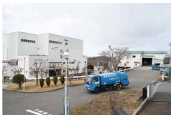
大規模改良工事を行うクリーンセンター
