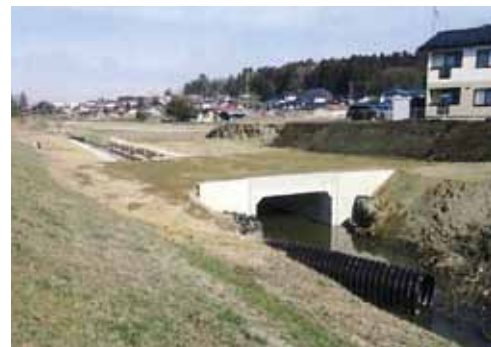
ボックスカルバートによる整備が進む 都市計画道路新山十文字線
